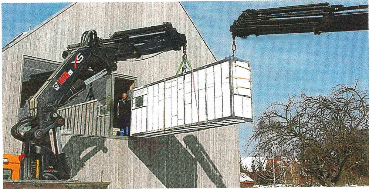
Der Einzugsstermin für Karpfen rückt näher. Das Aquarium wurde im Stück geliefert.
