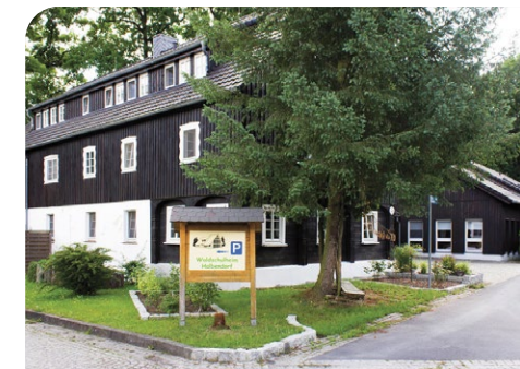
Das Wald- schulheim soll künftig besser vor Hochwasser geschützt sein.
